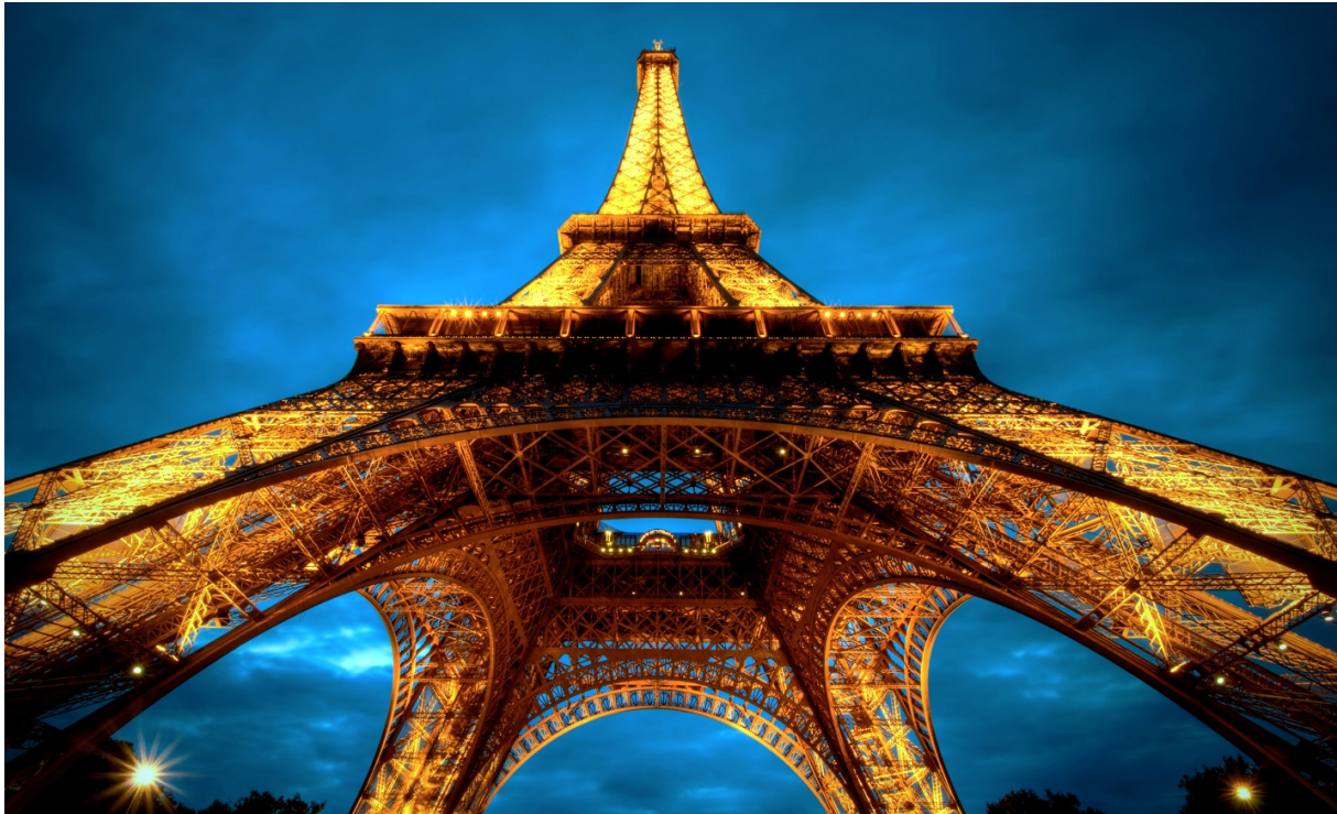
Hình 8: Tháp Eiffel ở Paris với 4 mặt như nhau, có nhóm đối xứng D_4 giống hình vuông.
